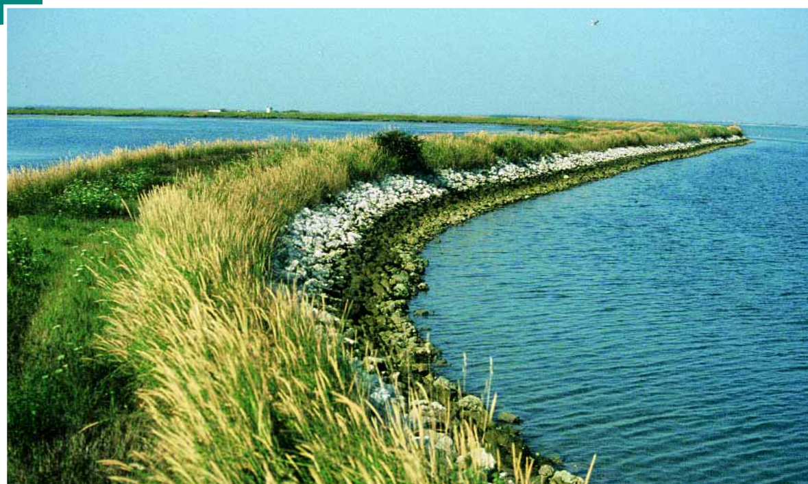
Massicciata difensiva di argine lagunare.
